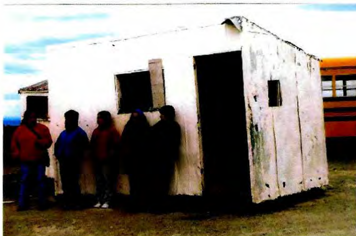
Refugio sin puertas ni ventanas
